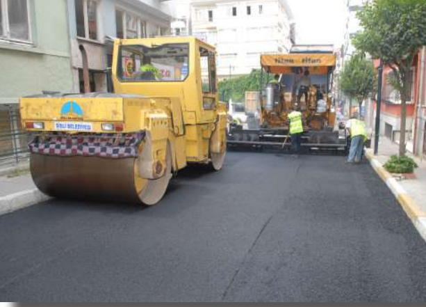
Ayazağa Asfalt Çalışması
