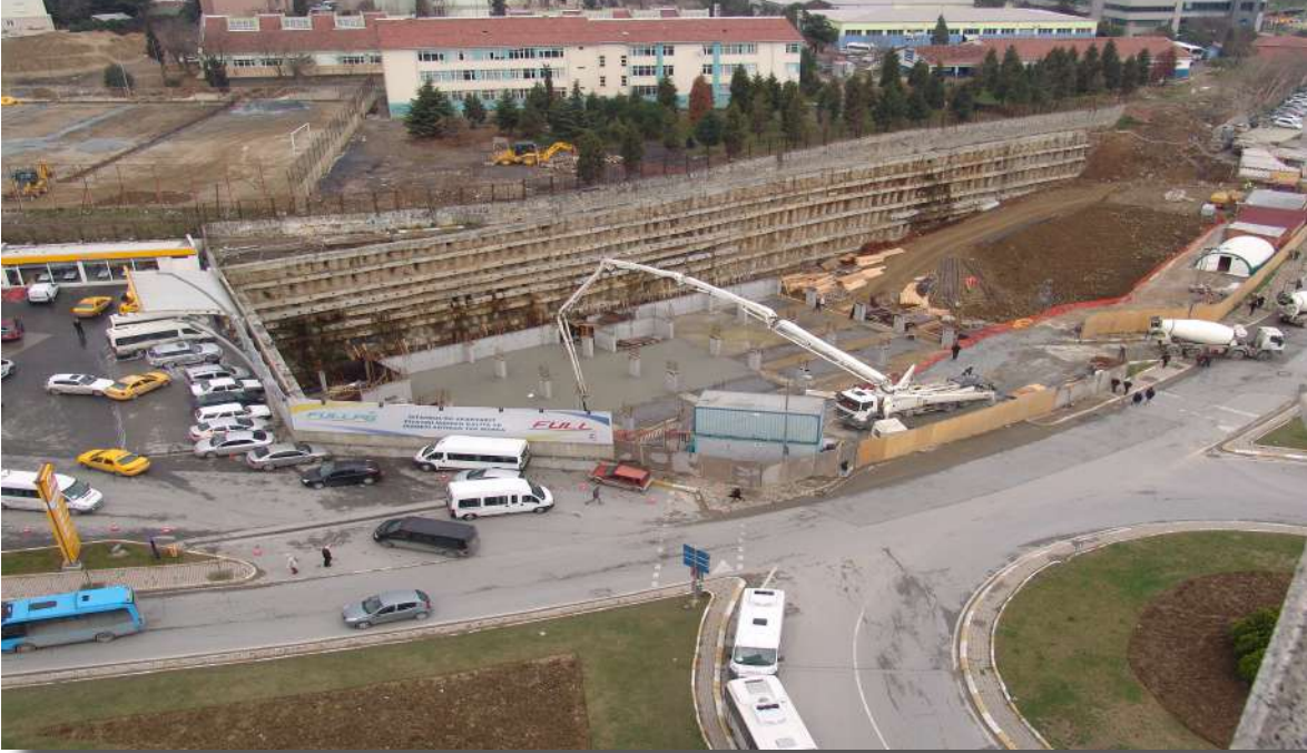
Yeni Hizmet Binası Temel İnşaatı
