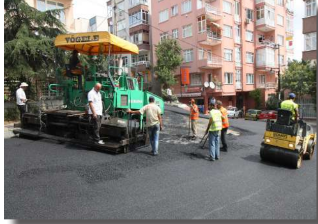
Fulya Asfalt Çalışması
